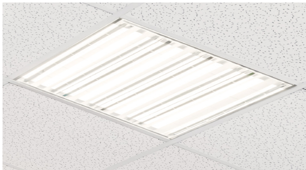
Alte Beleuchtung mit T8-Leuchtstoffröhren
